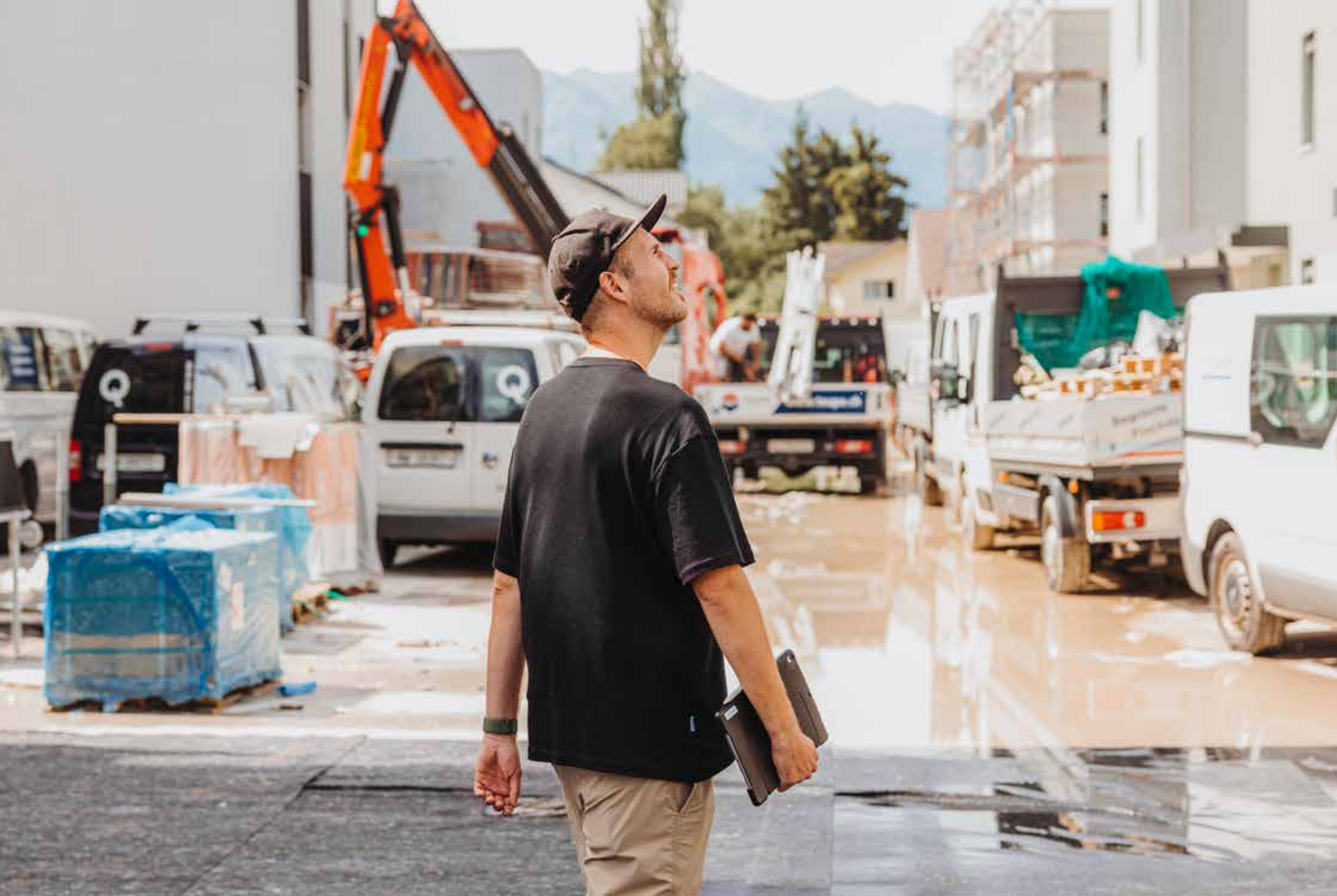
Joël Siegrist besichtigt «seine» Baustelle in Alpnachstad.
